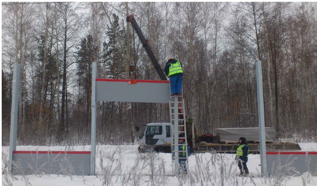
Рис.8. Монтаж шумопоглощающих панелей.
